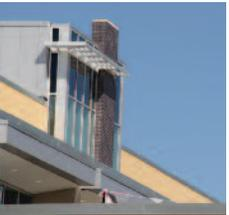
Exterior solar shading
